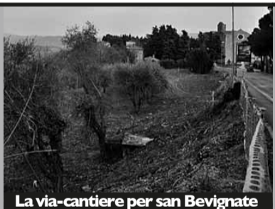
La via-cantiere per san Bevignate
