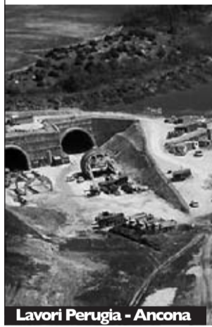
Lavori Perugia - Ancona
