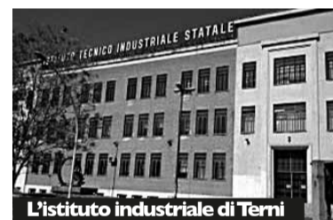
L'Istituto industriale di Terni
