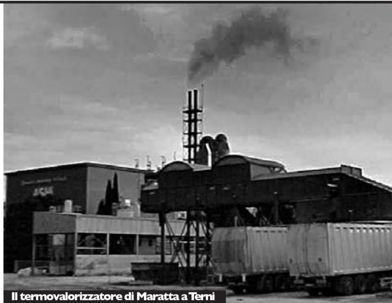
Il termovalorizzatore di Maratta a Terni
