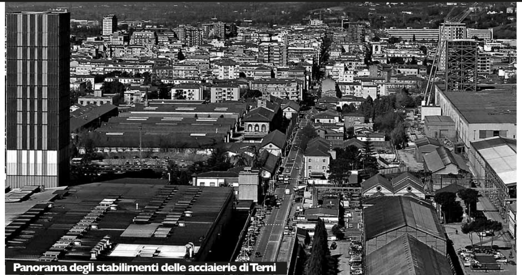
Panorama degli stabilimenti delle acciaierie di Terni
