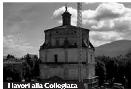
I lavori alla Collegiata
